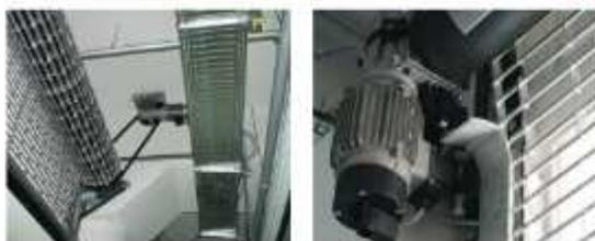
در سیستم کرکره های اتوماتیک بسته به نوع کاربرد آنها اعم از وزن وابعاد و میزان تردد از انواع مختلف موتور و تیغه استفاده می شود.
