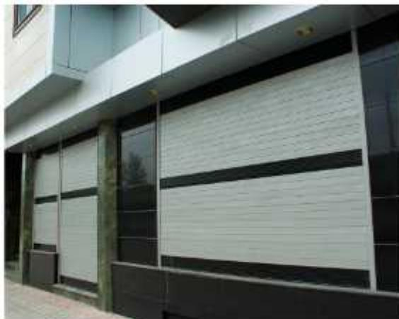
کرکره های اتوماتیک از نظر جنس به انواع مختلفی تقسیم می شوند از جمله آلومینیوم اکسترود، فومدار و شفاف (پلی کربنات) و....
